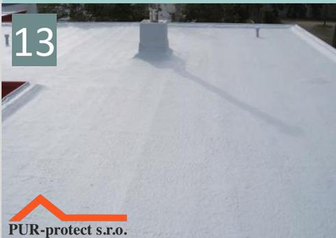
Wenn der Dachaufbau so beschichtet ist, dass kein Vlies mehr zu sehen ist und die Oberfläche gleichmäßig aussieht und glänzt, ist genügend Material aufgetragen worden.
